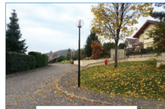
Un éclairage public à optimiser
