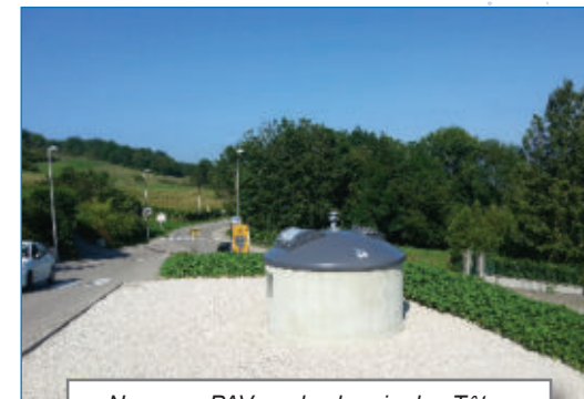
Nouveau PAV sur le chemin des Tâtes
