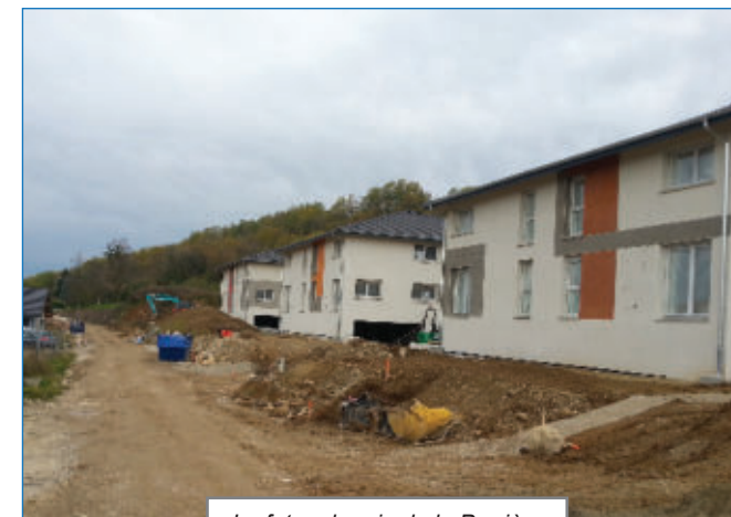
Le futur chemin de la Perrière
