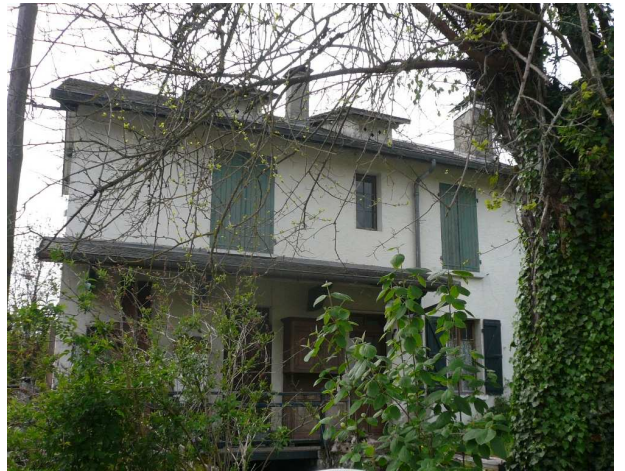
la maison aujourd'hui bâtie sur les fondations du château de Saillon
