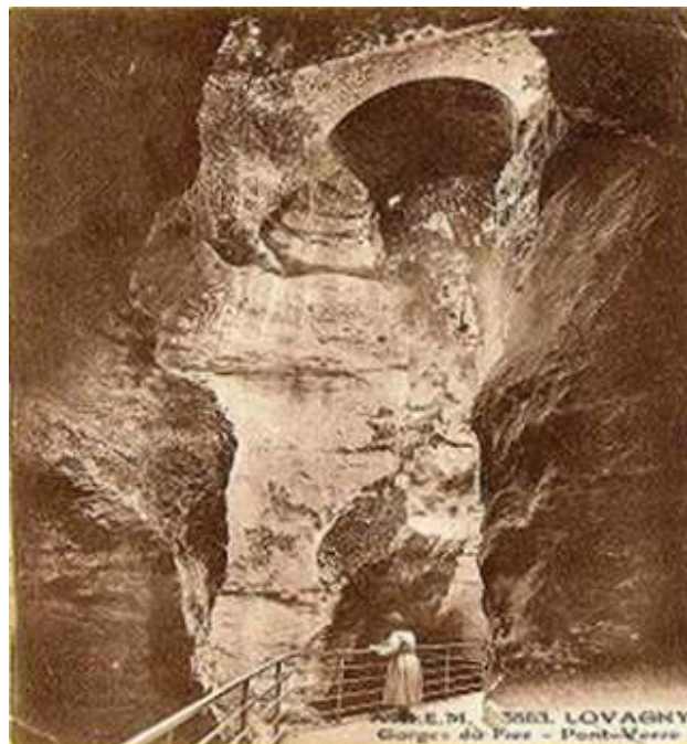
l'ancien pont de pierre avant sa reconstruction en 1956
